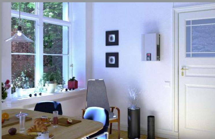
Устанавливать и эксплуатировать стабилизатор Гибрид рекомендуется в сухих и отапливаемых помещениях. Настенную установку рекомендуется производить в вертикальном положении (вентиляторами вверх), оставив сверху и снизу 10-15 см для охлаждения. Подключение осуществляется к существующей проводке через клеммную колодку для аппаратов от 5.5 до 9кВт и через встроенный шнур с вилкой и розеткой на корпусе стабилизатора для моделей 2.2 и 3.5кВт.
